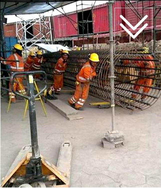
Servicio de suministro y habilitación de estructura pilotes para cimentación en Planta Unacem.
