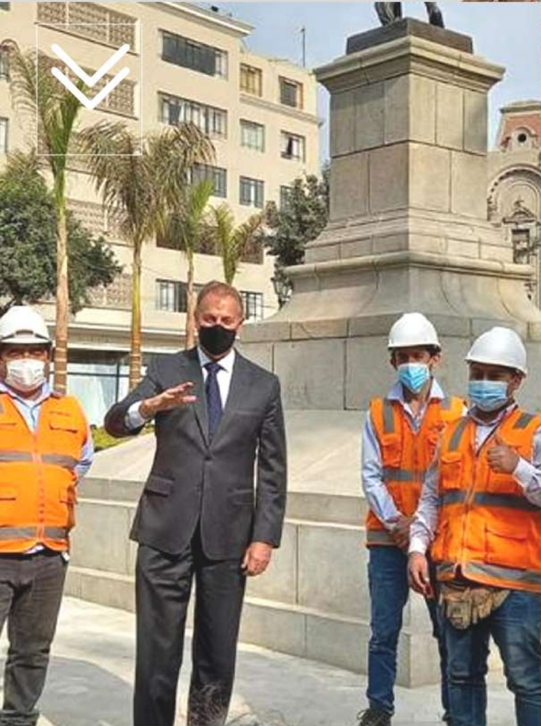
Servicio de mantenimiento de los pisos del espacio público de la Plaza Francia en El Centro Historico de Lima.
